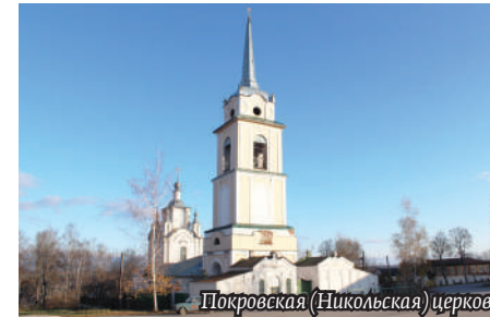
Покровская (Никольская) церковь
